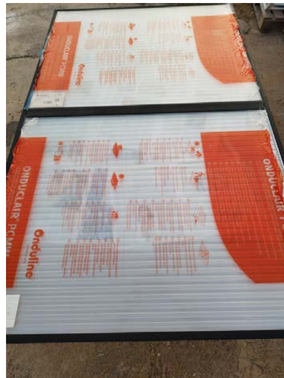
Preparación de la cubierta.
