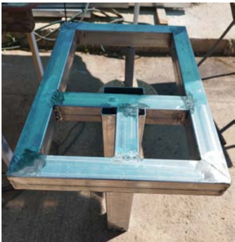
Fabricación de la nueva estructura.
