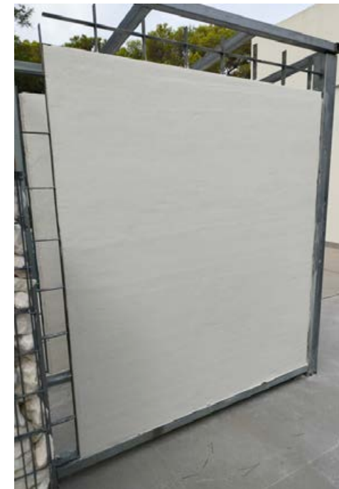
Superficie preparada para el acabado.
