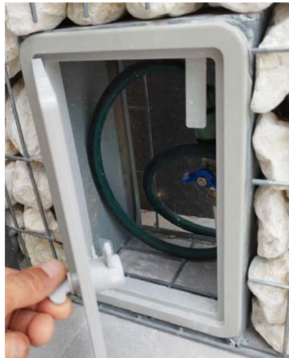
Acceso a la alimentación y al vaciado del depósito.
