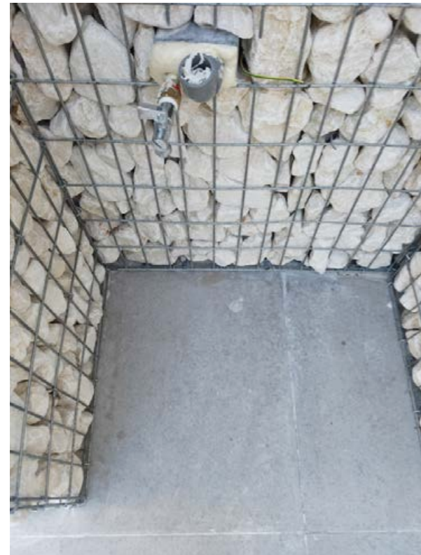
Integración de las conducciones en el gavión.
