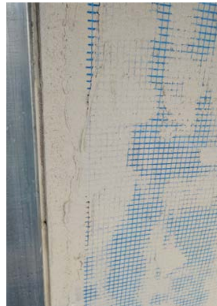
Refuerzo previo al revestimiento.
