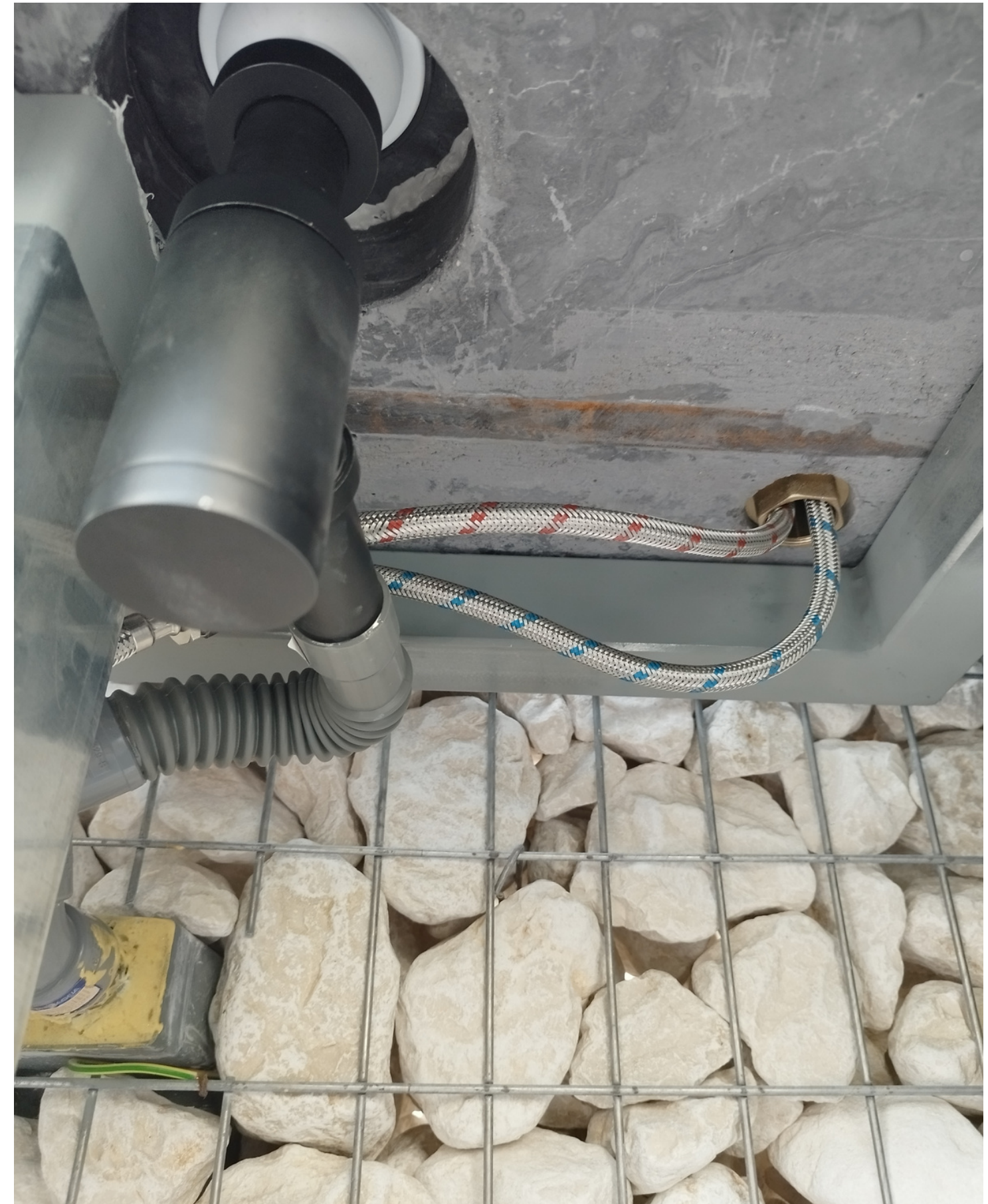
Conexiones terminadas y ocultas.
