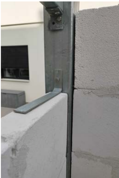
Anclaje entre fábrica y perfil metálico.
