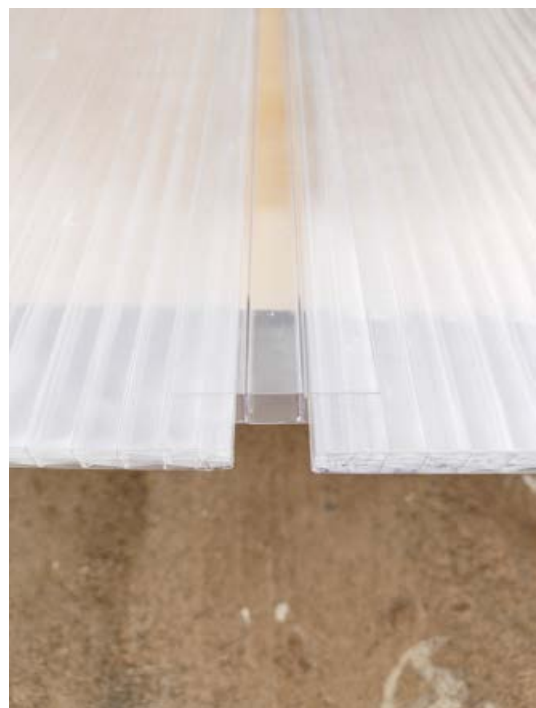
Unión entre placas.
