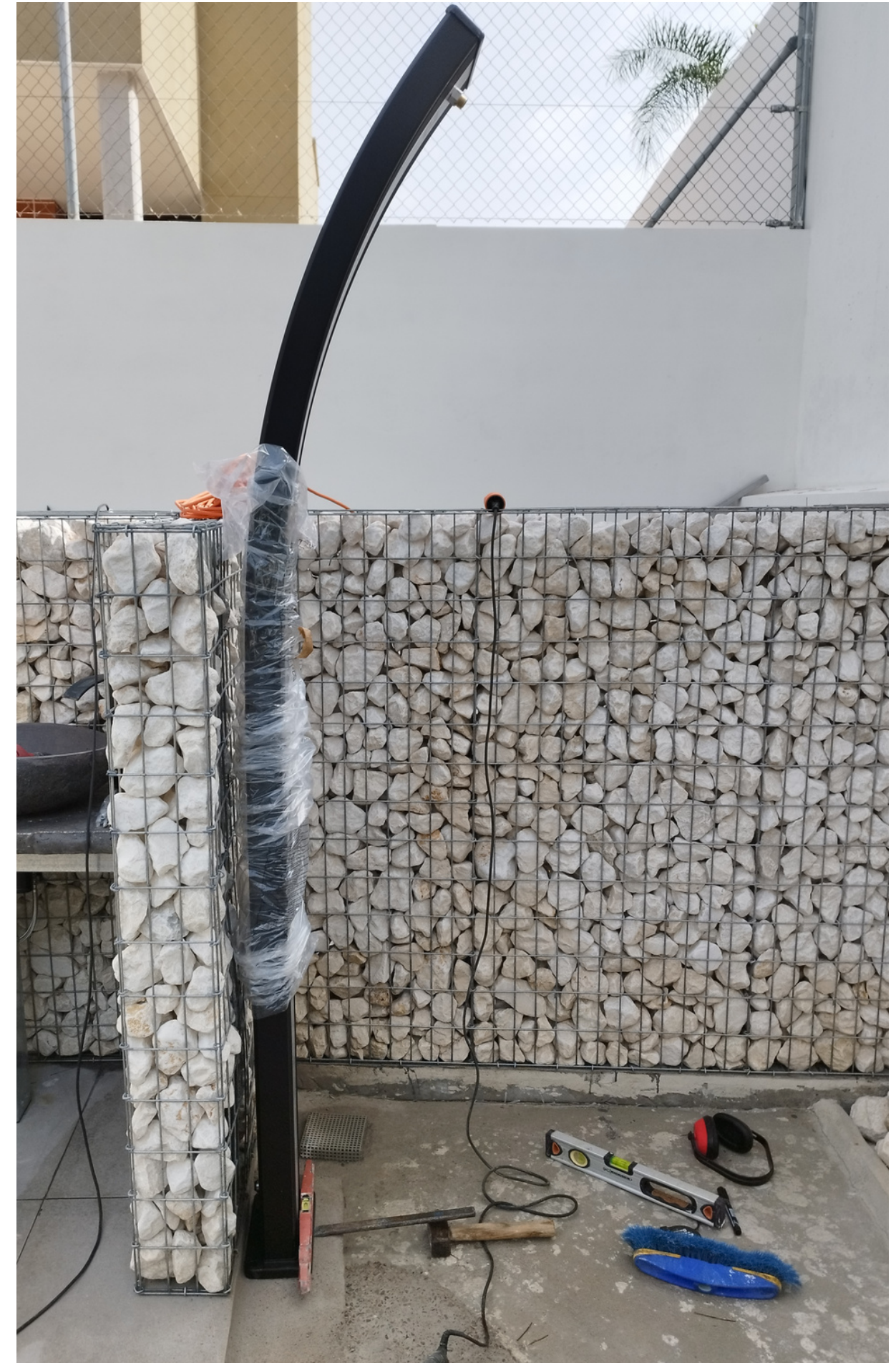
Integración de la ducha solar entre los gaviones.
