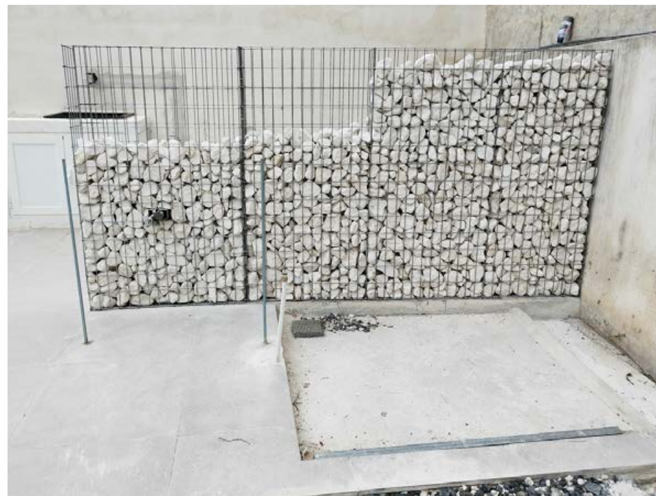
Construcción de gaviones.
