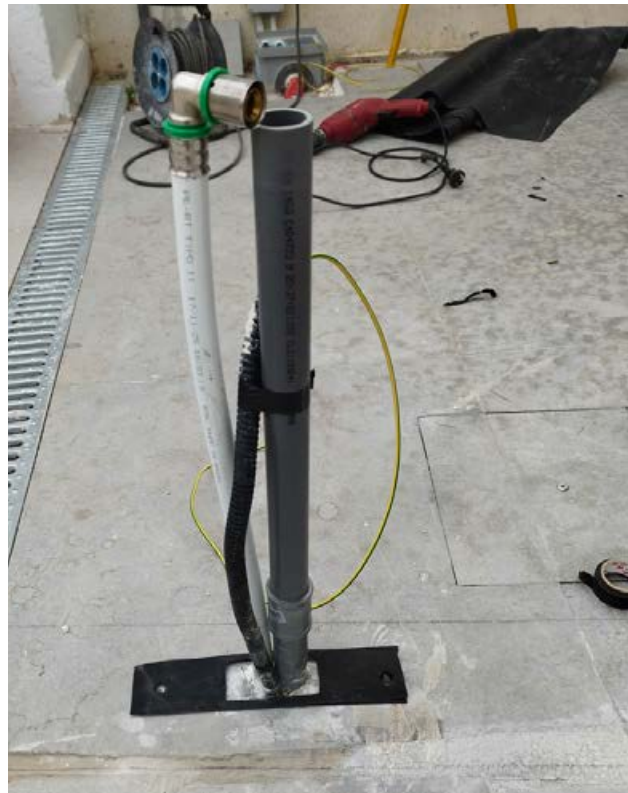
Instalaciones previstas antes del relleno.
